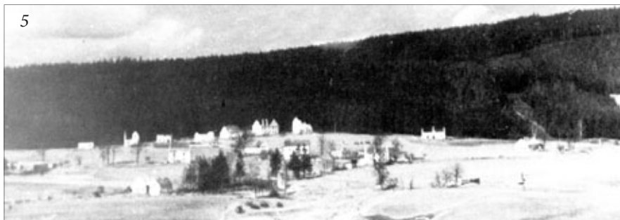
4 – 5 – Demolice domů na Dubině – budování hraničního pásma
