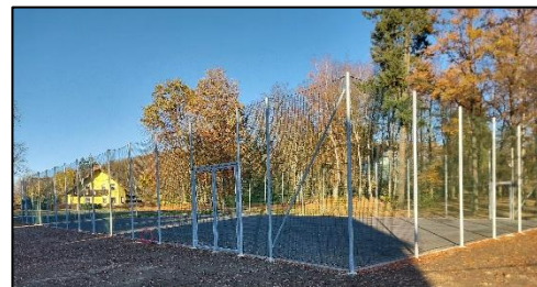
Obrázek 4 – Víceúčelové hřiště před dokončením
