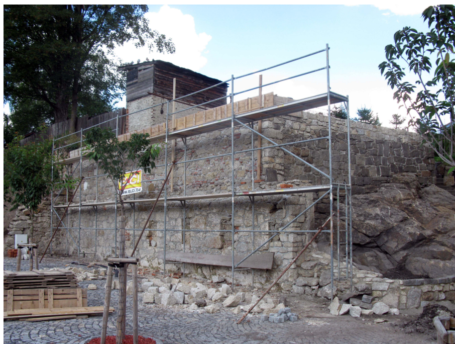
Rekonstrukce původní zdi na návsi
